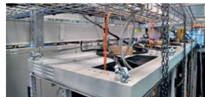
Podizanje postojećih IKT ormara za 5 – 10 cm iznad nivoa postojećeg poda radi njegove zamjene
