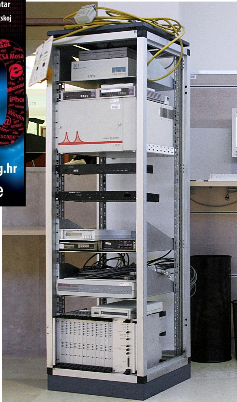
Oprema kojom je Hrvatska u studenom 1992. godine spojena na Internet ((radilo se o vezi između Srca i Sveučilišta u Beču kapaciteta 9.6 kbps)
